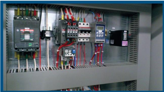
Щиты станций управления - ЩСУ предназначены для местного, дистанционного и автоматического управления различными технологическими процессами, такими как управление системами приточной и вытяжной вентиляции, насосами с асинхронными электродвигателями, работающими в трехфазных сетях переменного тока напряжением 380/220В частотой 50Гц. Щиты ЩСУ устанавливаются в производственных, административных, промышленных зданиях.
