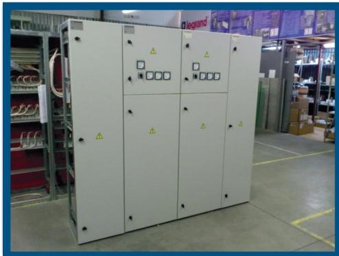
Устройства вводно-распределительные (ВРУ) предназначены для приёма, распределения и учета электрической энергии напряжением 380/220 В переменного тока частотой 50 Гц в четырехпроводных и пятипроводных сетях с системами заземления TN-C, TN-C-S.
