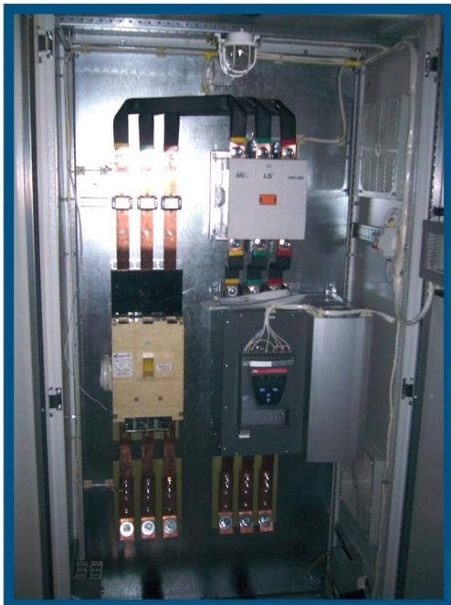
Шкафы плавного пуска электропривода серии ШПП - низковольтные комплектные устройства, предназначенные для плавного пуска и останова асинхронных двигателей. ШПП обеспечивают запуск двигателя путем подачи на него медленно нарастающего напряжения, обеспечивая мягкий пуск и плавный разгон при помощи минимального тока, необходимого для запуска двигателя. После разгона происходит переключение двигателя на сеть шунтирующим контактором.
